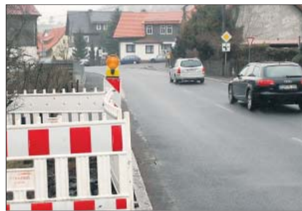
Ab heute wird in Sachsenbrunn gebaut.
